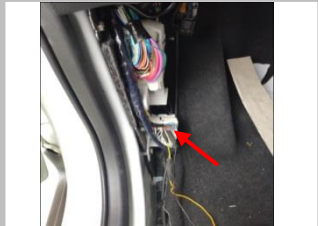
3.17 接 CAN 线：在主驾驶室 A 柱左侧拆下盖板，看到原线束
